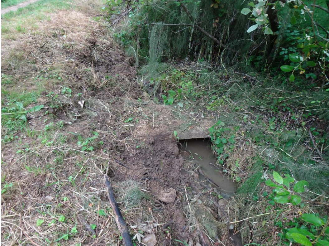
Figure 13 : Berges en mauvais état : non entretenues, érodées – BV6 (Source : Actierra 16/07/2025)
