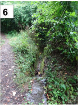
Débris ligneux et végétation dans l'ouvrage de collecte
