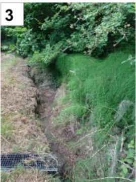
Fossé d'écoulement des EP - berges instables
