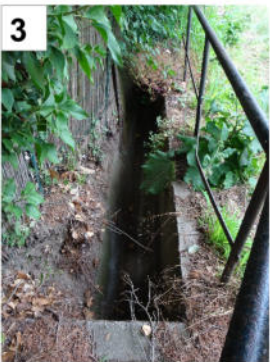
Ouvrage de collecte des eaux de ruissellement - état dégradé
