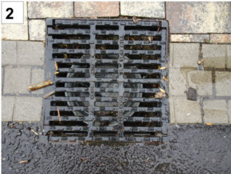
Grille EP avec bac de récupération des déchets (Chemin des Grandes Vignes)
