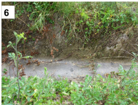
Petits débris ligneux dans l'ouvrage de collecte des EP
