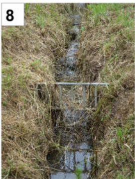
Fossé avec des seuils et une grille. Berges non entretenues
