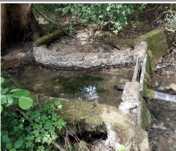
Photo 2. Arrivée du ruisseau dans un bassin maçoné
