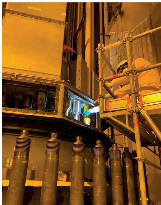
Vérification d'un couvercle de cuve lors d'une épreuve hydraulique* à la centrale nucléaire de Cattenom (Moselle).
