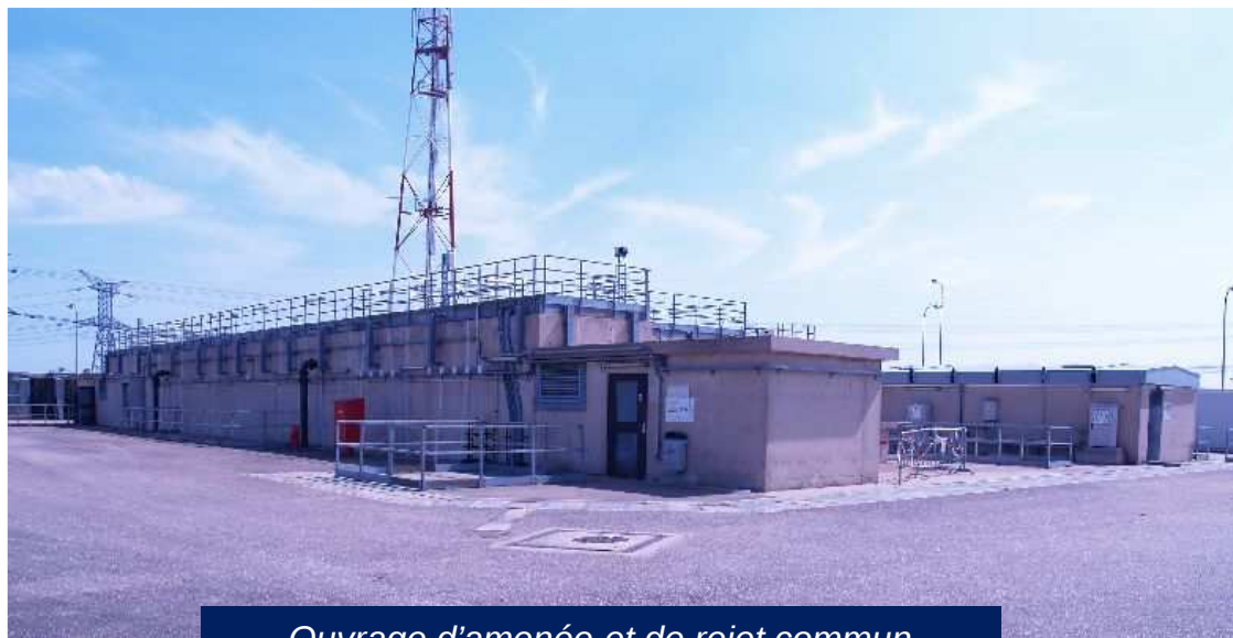
Ouvrage d'amenée et de rejet commun aux unités n°3 et n°4 (hors zone nucléaire).
