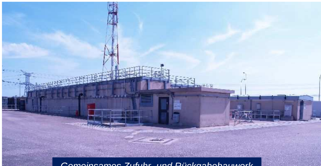
Gemeinsames Zufuhr- und Rückgabebauwerk von Block 3 und 4 (außerhalb der Nuklearzone)
